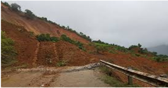
Hình 1: Sạt trượt mái dốc Quốc lộ 24
